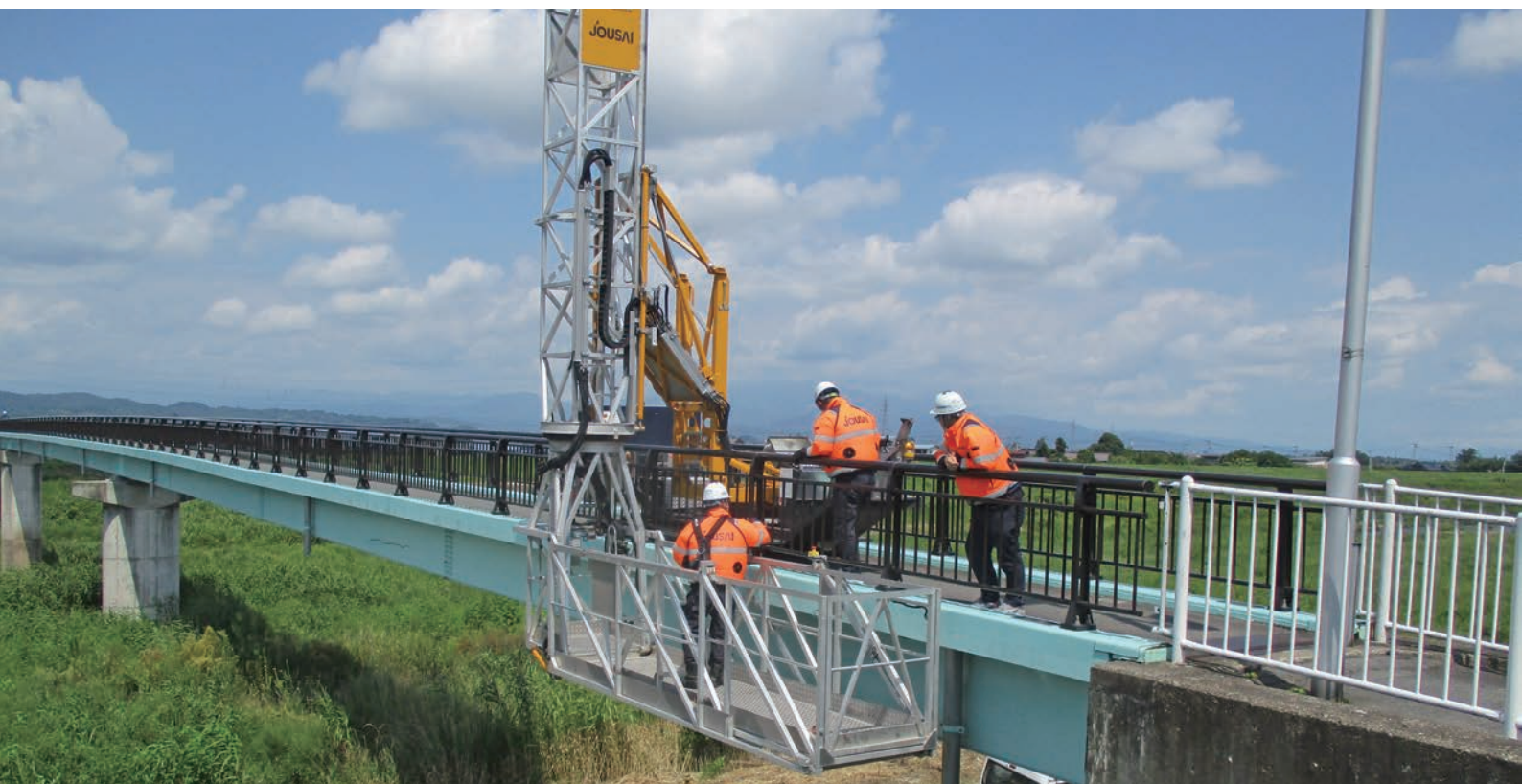
小規模点検車を利用した橋梁点検の実施
