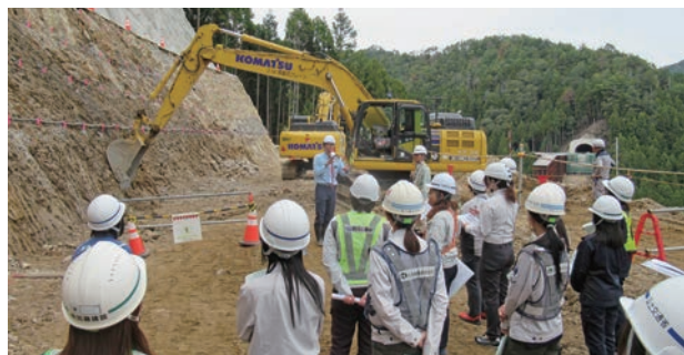
ICT建設機械を用いた施工の現場見学
