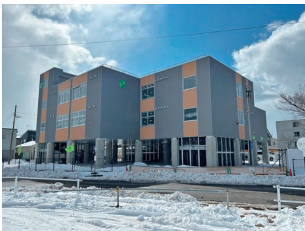
津波避難タワー（いづみ公園）
