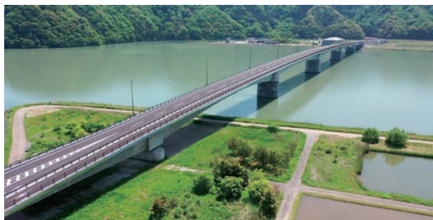
城崎大橋全景（円山川左岸よりドローン撮影）
