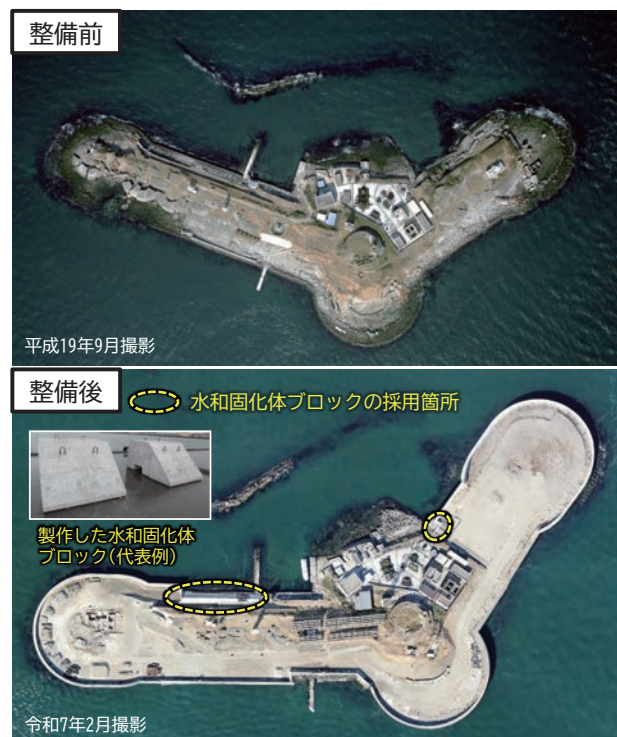
第二海堡護岸の整備前後の状況と水和固化体ブロックの採用箇所
