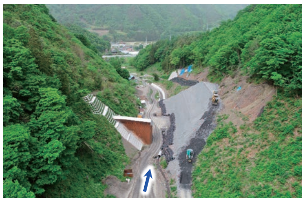
施工状況（応急押え盛土）
