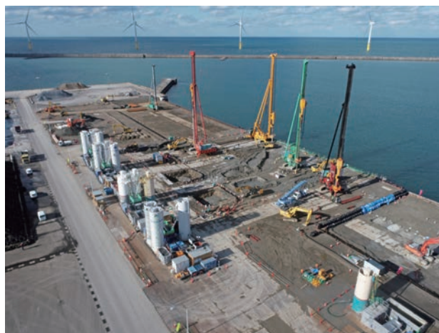
深層混合処理工法による施工状況
