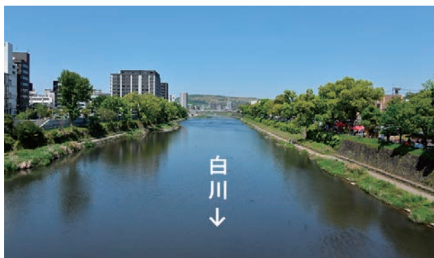
整備後の白川「緑の区間」
