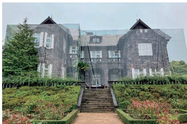
洋館の外観をプリントしたメッシュシートの仮設足場
