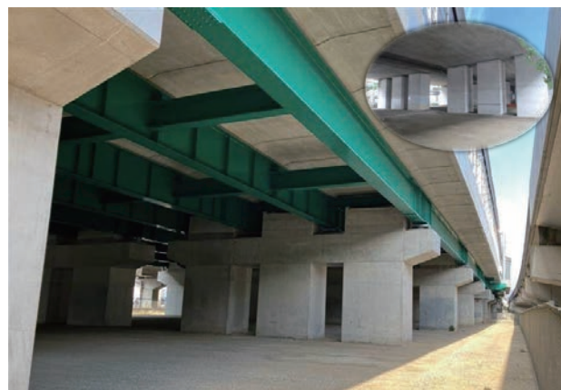
RC中空床版橋の更新
