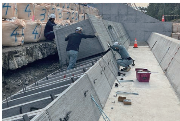
埋設型枠ブロックの据付
