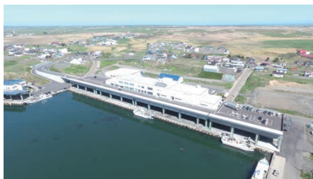
歯舞漁港人工地盤関連施設の全景
