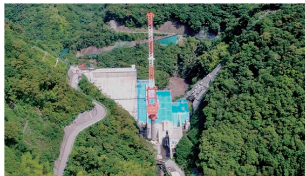
長期休止期間中の養生（平成29年4月）
