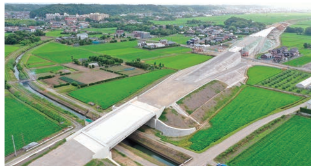
二期区間・施工中航空写真
