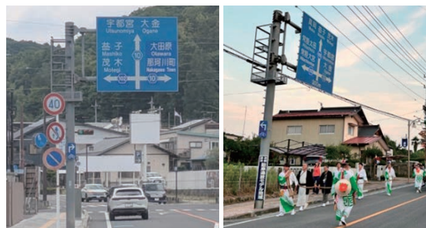
回転可能構造の大型案内標識板
