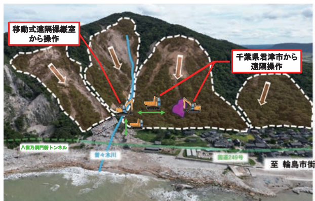
落石の危険性を伴う地すべり対策工事 (石川県輪島市曾々木地区)
