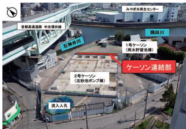
王子第二ポンプ所（施工中）
