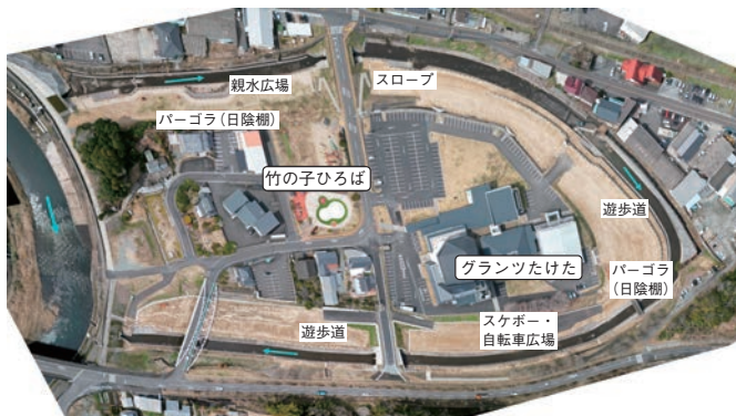
事業箇所の空撮
