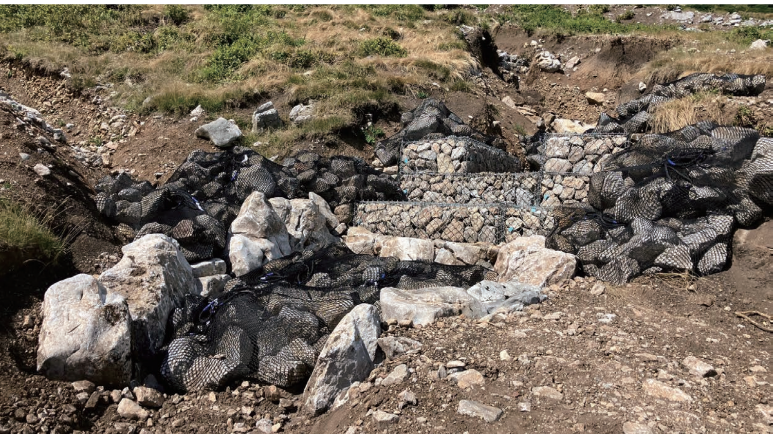
多段積みかごマット堰堤による勾配緩和と流速低減・土砂流出抑制
