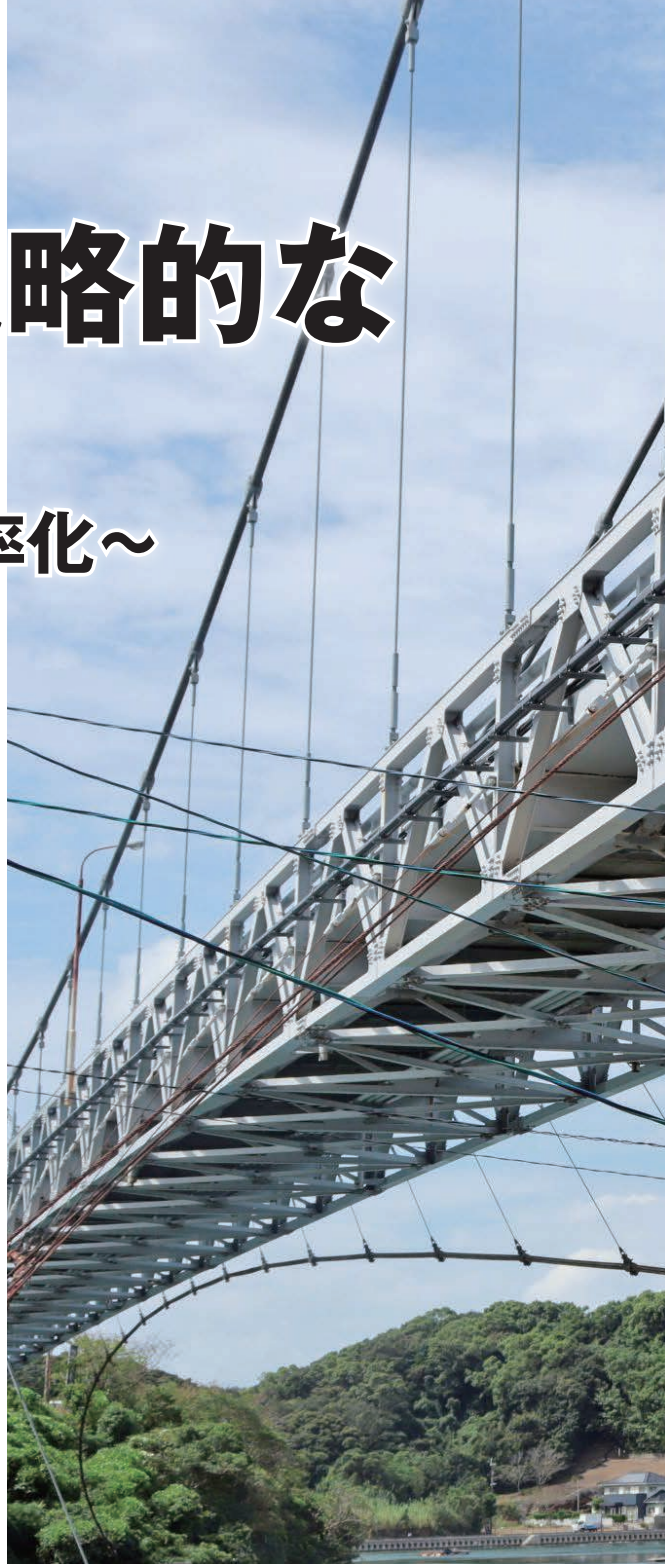
道路メンテナンス技術集団による、樋島大橋の直轄診断現地調査（今号P16～18「吊橋である樋島大橋（上天草市）の直轄診断」より）
