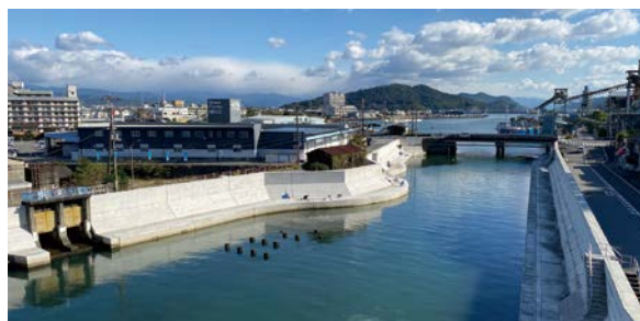
浦戸湾地区 西孕防潮堤
