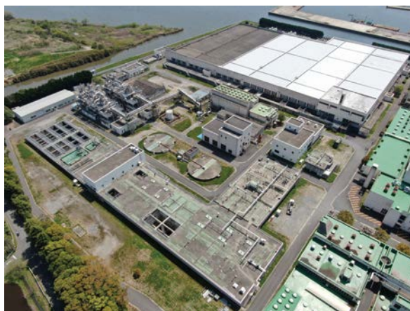
霞ヶ浦浄化センター（土浦市）
