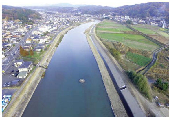
島田川平成30年7月豪雨災害対応 河川改修後
