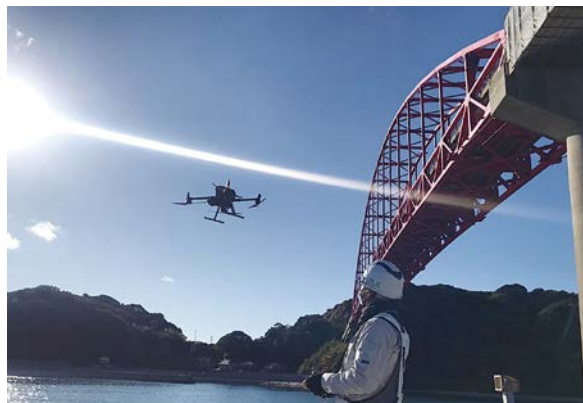
ドローンを活用した橋梁点検
