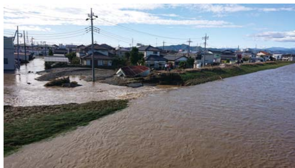
令和元年東日本台風 秋山川の決壊状況
