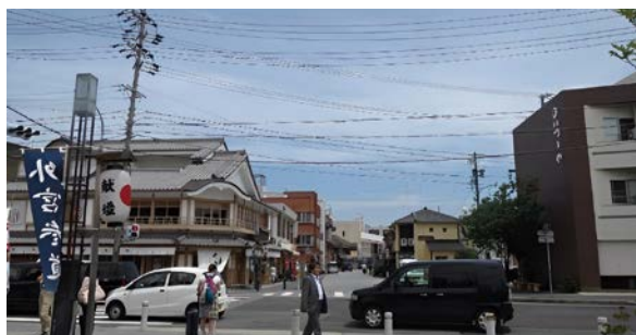
無電柱化施工前
