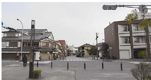
無電柱化施工後
