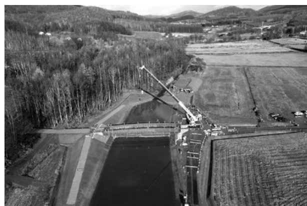
橋梁架設状況（比布川広域河川改修工事）
