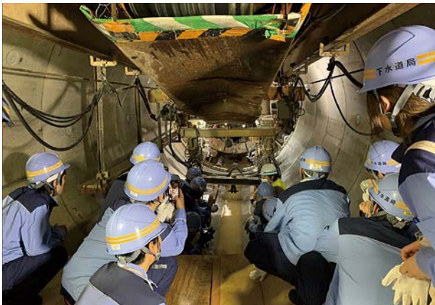
写真-3 シールド工事現場の見学会の様子
