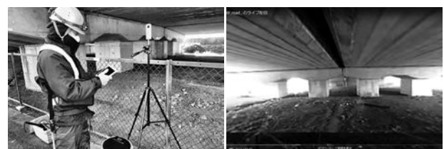
写真-3 B橋・桁下の状況 (全方位カメラ映像)
