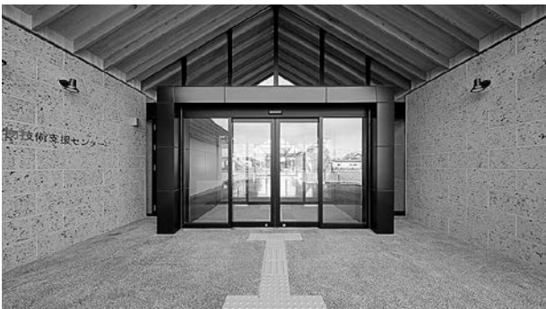
写真－4 エントランス（壁は大谷石張り）
