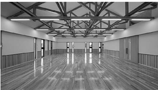
写真－5 会議室（トラス架構）
