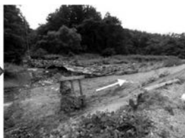
写真-2 被災後の写真
