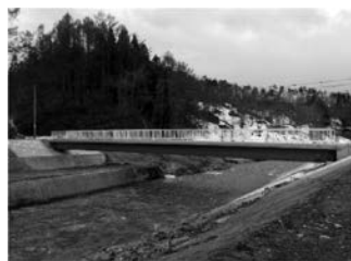
写真-3 完成した永久橋
