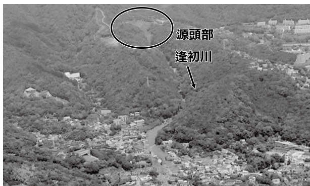
写真-1 被災状況（あおぞら号撮影）
