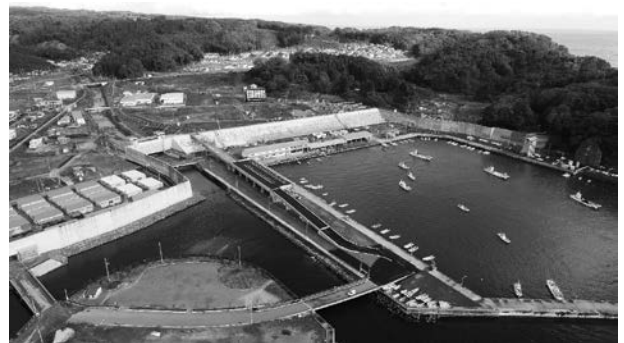
写真－2 田老漁港海岸の復旧状況
