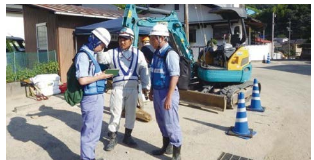
写真-4 土砂撤去支援状況
