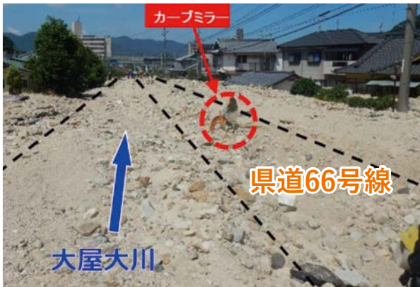
写真-1 土砂・洪水氾濫の状況（呉市天応地区）
