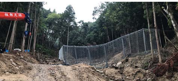
写真-5 強靱ワイヤーネット設置状況(口田南3丁目)
