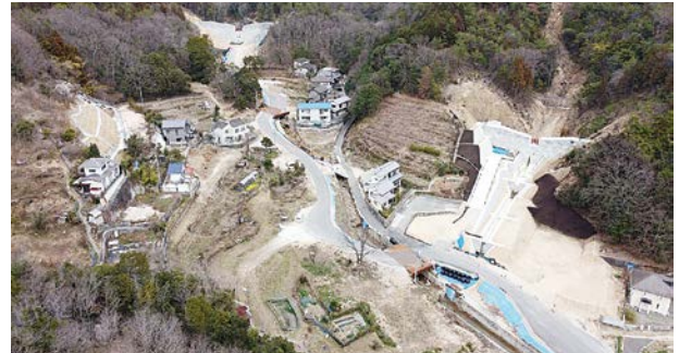
写真-6 砂防堰堤整備状況(天応地区)
