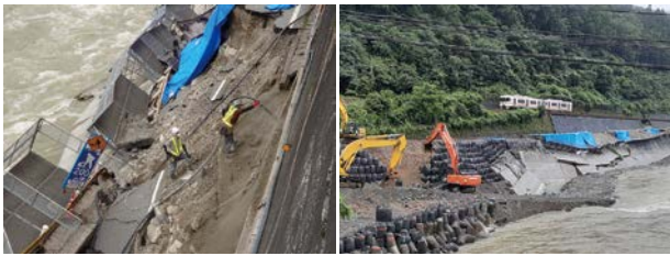
写真-5 モルタル吹付 写真-6 鉄道運行再開
