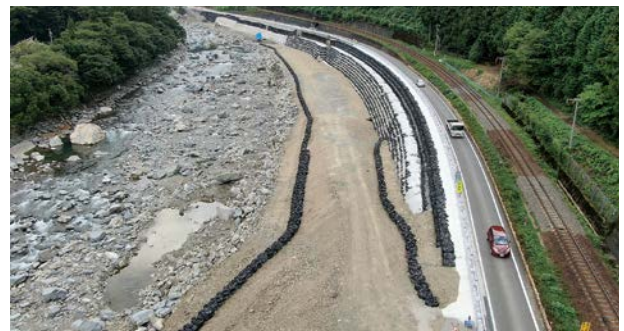
写真-8 令和2年8月17日 開通（片側交互通行）
