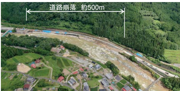
写真-2 道路崩落 全体
