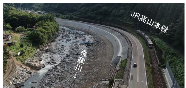
写真-9 令和3年7月28日 本復旧完了
