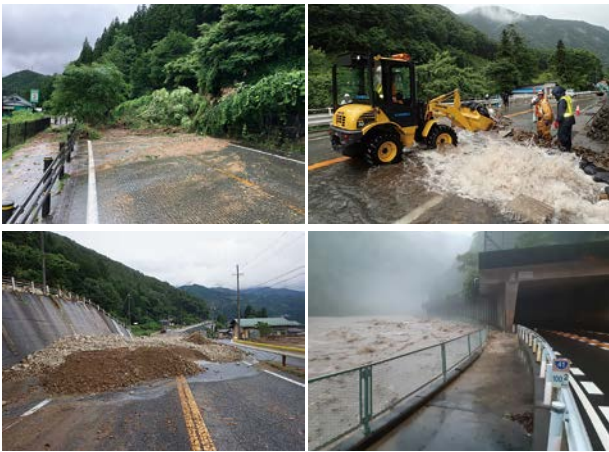
写真-1 国道41号 被災状況
