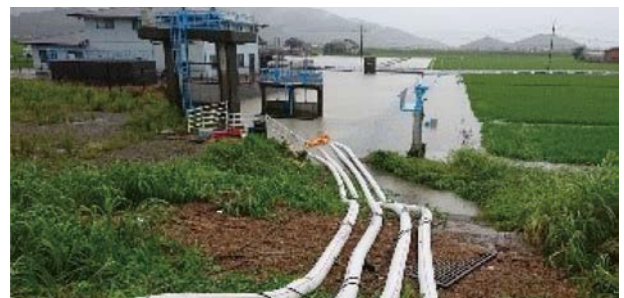
写真-7 排水ポンプ車による浸水排除（佐賀県大町町）
