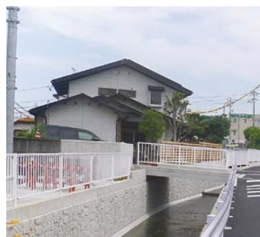
河川改修 (清水区平川地区)
