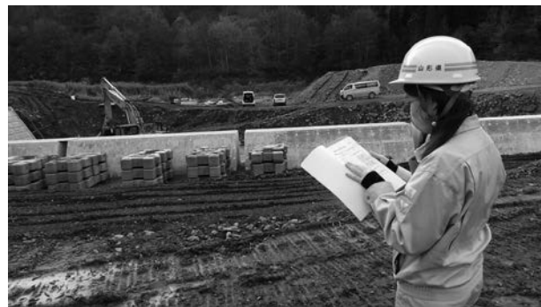
ダムの貯砂捕捉施設の建設現場の視察状況
