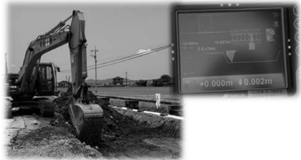
写真-3 バックホウMG施工状況
