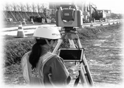
写真-1 起工測量状況
