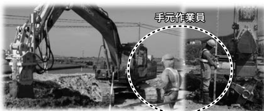
写真-5 重機近接作業状況 (従来)
