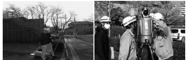
写真-4 舗装修繕工の検証状況
