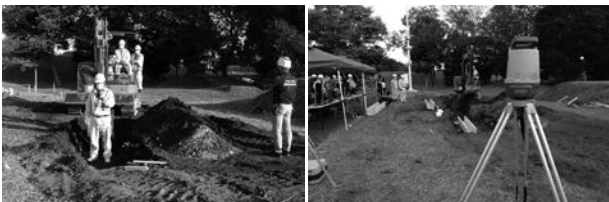
写真-3 構造物設置工の検証状況
