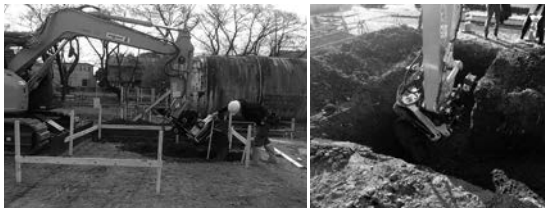
写真-2 小規模土工（管路設置）検証状況
