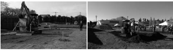
写真-1 小規模土工（敷均・整正）検証状況
