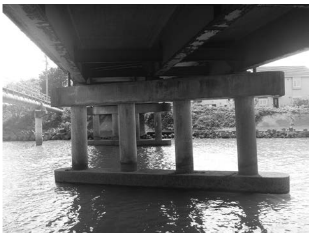
写真-3 パイルベント橋脚の状況
