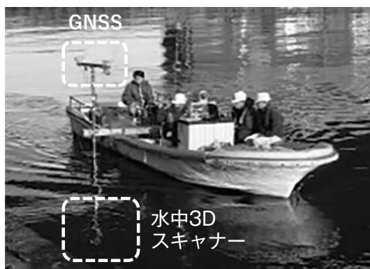
写真-1 水中3Dスキャナーを用いた点検の実証状況
