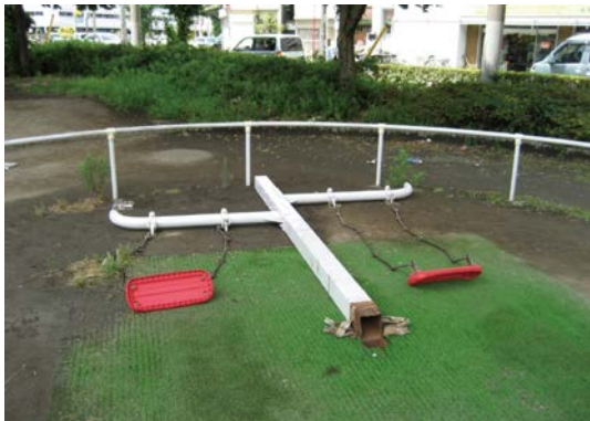
写真-2 平成19年度に起きた1本柱ブランコの倒壊事故
