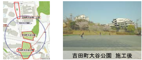
公園施設改良工事【吉田町大谷公園】
