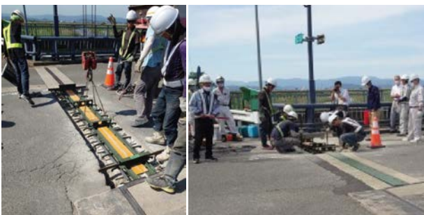
写真-3 工業技術センター等で開発した伸縮装置
