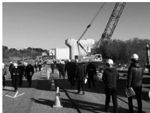
現場研修の様子 （仮称）新愛岐大橋の整備
