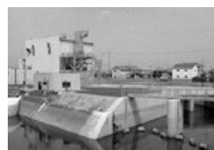
写真-5 角ノ瀬排水機場 20m 3 /s完成（平成21年） <計画40m 3 /s>
