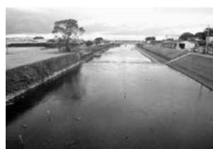
写真-4 加減堰右岸側撤去 (平成25年)
