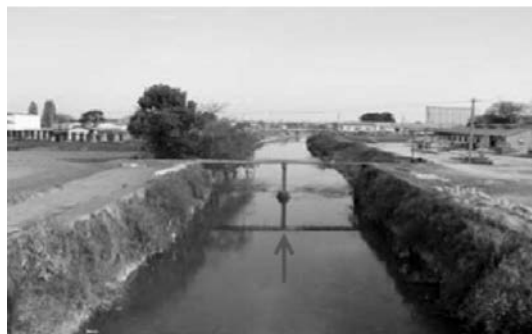
写真-2 加減堰（平成16年当時）
