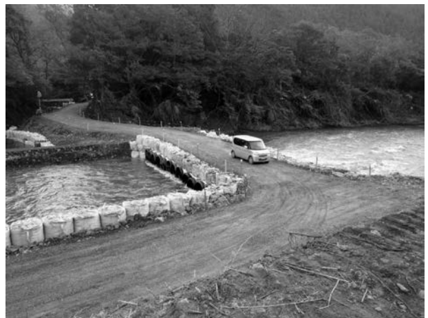
写真-2 完成した仮道（応急路）
