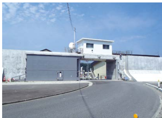
写真-2 神林3号陸閘（宮古市）
