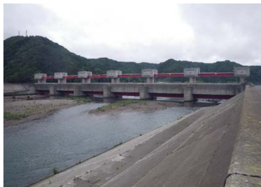
写真-1 小本川水門（岩泉町）
