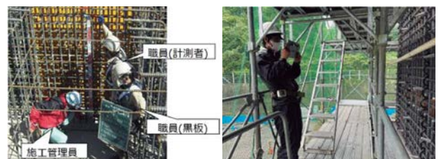
写真-1 従来の出来高計測 写真-2 出来高自動計測の状況
