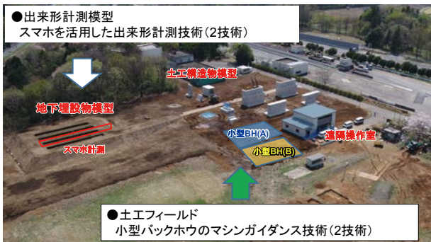
写真－2 建設DX実験フィールド
