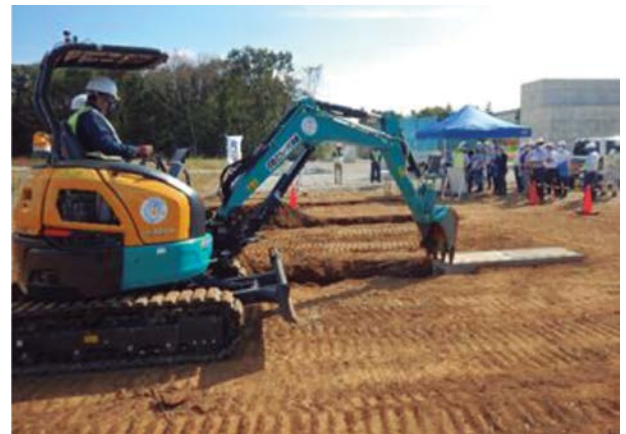
写真－3 小型バックホウのMG施工状況
