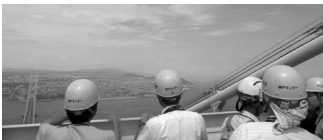
世界最長の吊り橋「明石海峡大橋」の3P塔頂から視察
