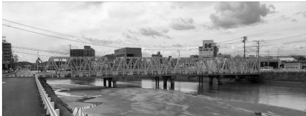
九十九橋（全景）
