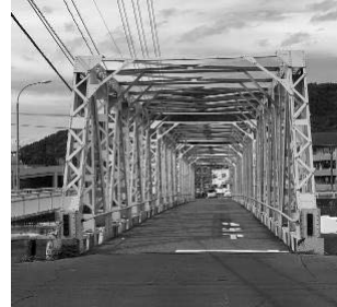
先人の苦勞 トラス部材の様子
