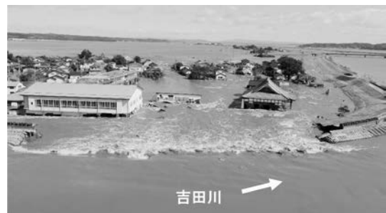
写真-3 令和元年東日本台風による吉田川の堤防決壊 (北上川下流河川事務所)
