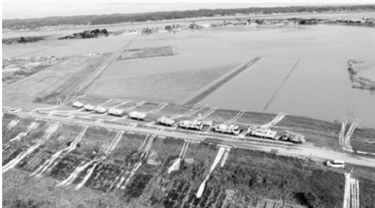
写真-5 全国から駆けつけたポンプ車による24時間体制での排水作業 (北上川下流河川事務所)
