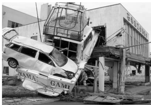
写真-1 東日本大震災・津波による石巻市街地の被害（北上川下流河川事務所）
