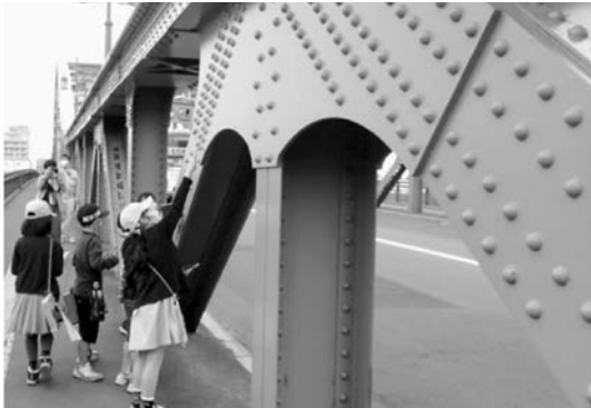
写真－5 現地調査の様子
