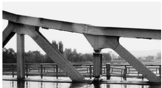
写真－2 ロッキングカラム
