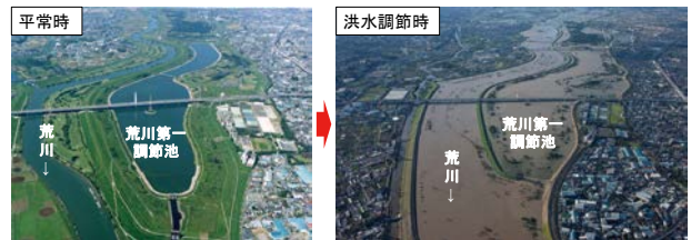
写真-1 荒川第一調節池
