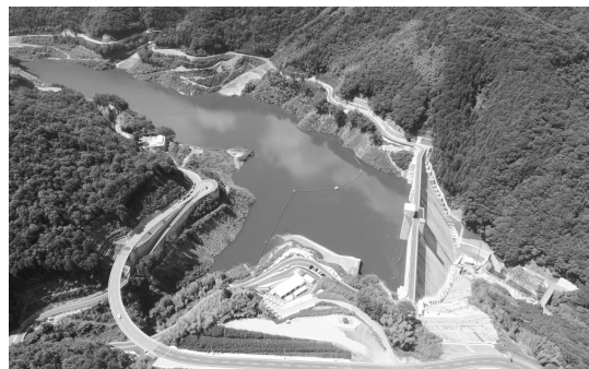
梶川ダム試験湛水状況（令和3年7月27日時点）
