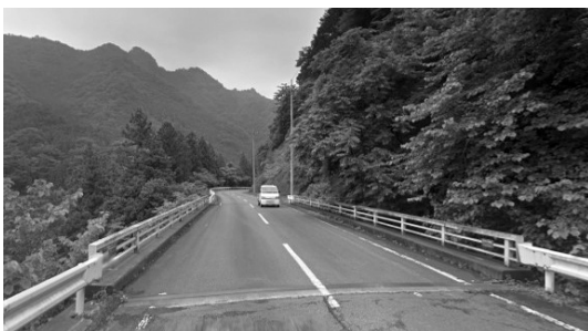
写真-1 約35年経過した橋
