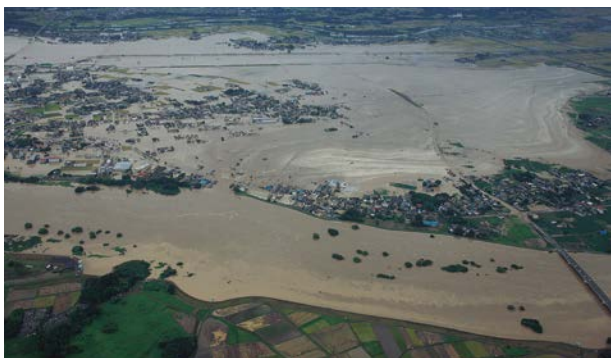
写真-1 鬼怒川の氾濫状況
