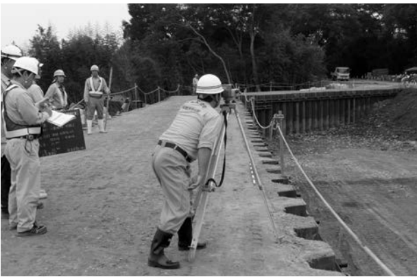
写真-6 完成した鋼矢板二重締切工
