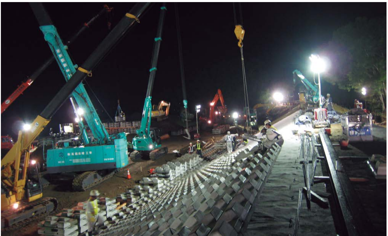
写真-4 昼夜を問わず施工する緊急復旧工事（接続ブロックによる法覆工）
