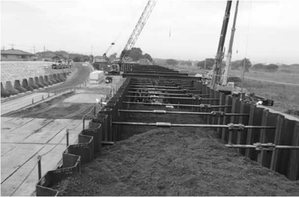
写真-5 鋼矢板二重締切工を施工
