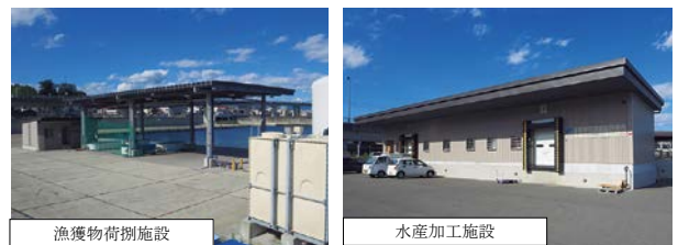
写真-4 蓄養周辺施設状況
