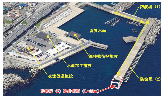
写真－2 蓄養水面周辺写真
