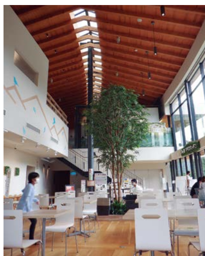
写真-4 屋根の構造材に地元のヒノキを活用
