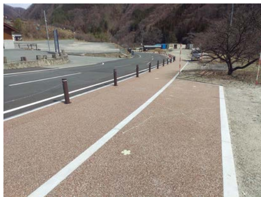
写真－5 完成後の歩道（昼間）
