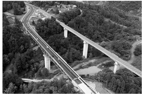
開通後の新しい妙高大橋（写真左）と現橋（写真右）
