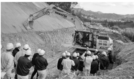
写真-2 ICT土工現場現場見学会
