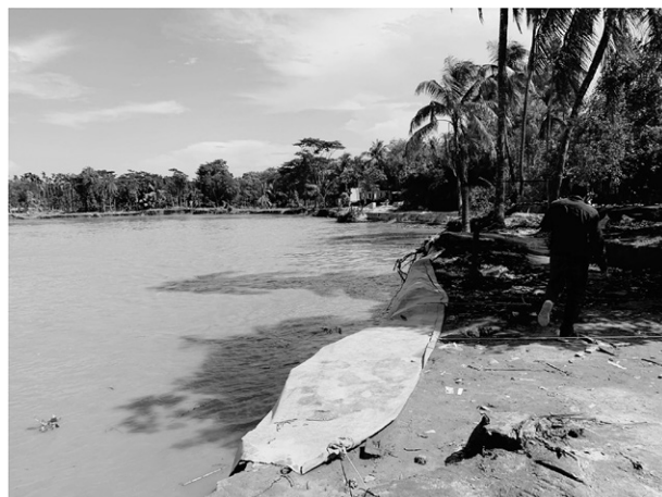
写真－1 大規模な侵食が発生した河岸 (Naria 地区パドマ川 2019年10月16日撮影)
