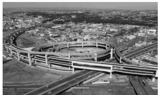
写真－1 首都高速神奈川7号横浜北西線（神奈川県横浜市）
